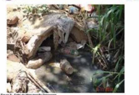
Figura 9 - Falta de Manutenção Drenagem
